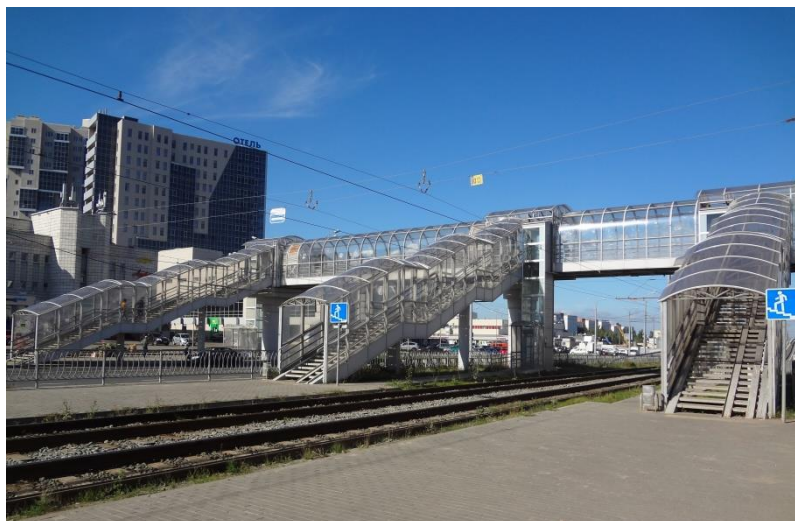
Рисунок 38 – Подход к трамвайным остановкам на ул. Рихарда Зорге
